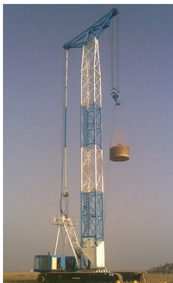
图 2 葫芦岛某船厂强夯施工
